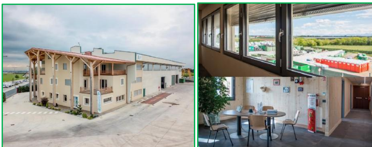
Figura 12 – Palazzina degli uffici di AMBIENTE SERVIZI
