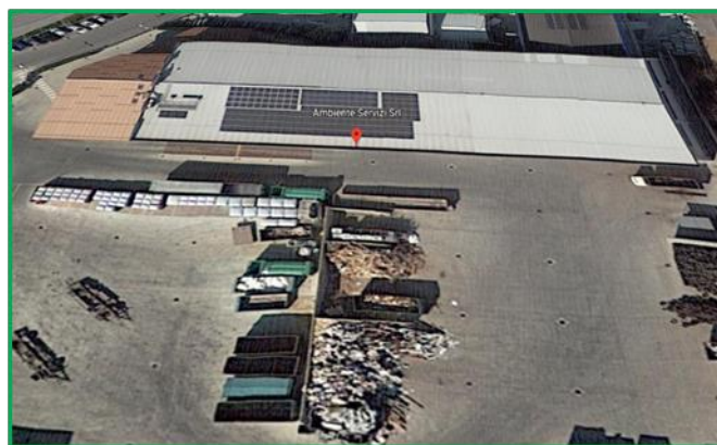
Figura 14 – Impianto fotovoltaico installato presso la sede operativa AMBIENTE SERVIZI
