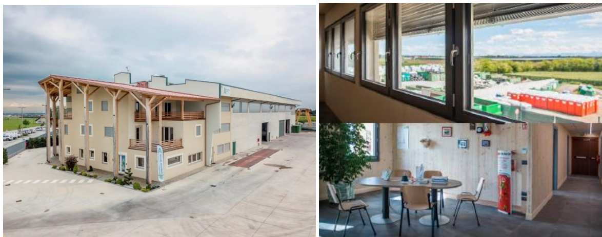
Figura 13 – Palazzina degli uffici di AMBIENTE SERVIZI
